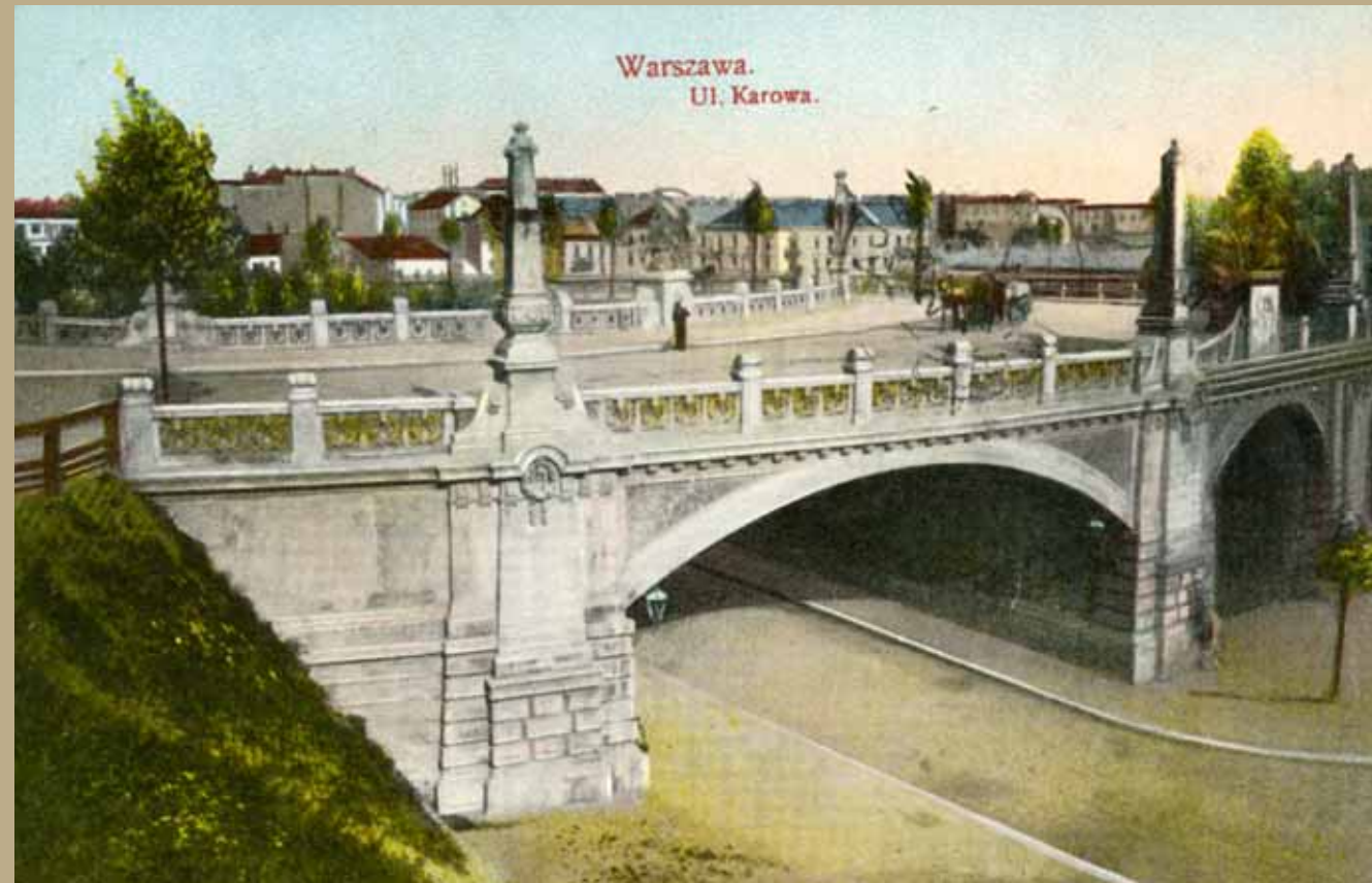
Ulica Karowa — wiadukt S. Markiewicza, przed sierpniem 1915 (72/1622/311)
