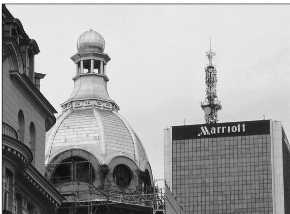
Hełm kamienicy Wilhelma Rakmana po remoncie. Lato 2008 r. Fot. J. Sujecki
