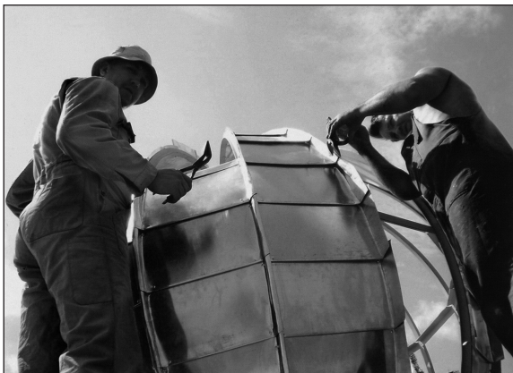
Edward Andrzejczuk (z lewej) i Robert Duraj pokrywają blachą konstrukcję kuli. Fot. J. Sujecki
