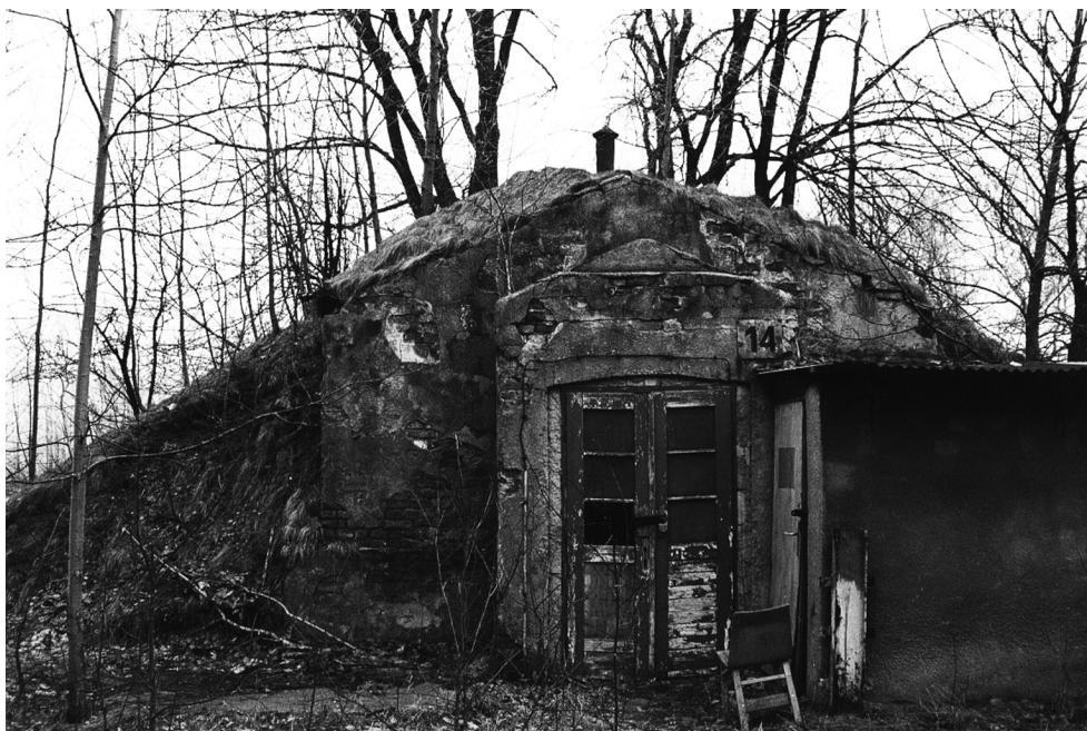
3. Lodownia przy Forcie Nr II. Elewacja zachodnia (fot. P. Boguszewski, 2006 rok)
