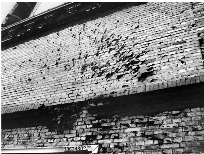
Ślad po eksplozji pocisku artyleryjskiego na elewacji piekarni od strony ul. Wiatracznej. Stan z kwietnia 2007 r. Fot. J. Sujecki
