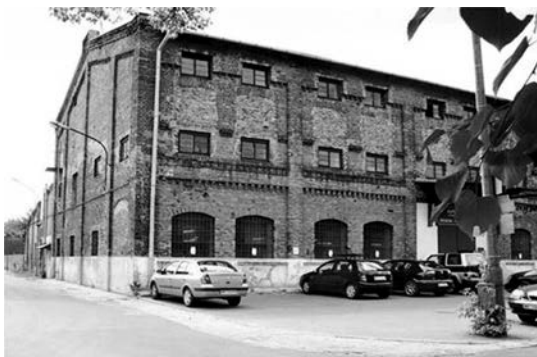
Budynek dawnej „Juty” na terenie ul. Mińskiej 25. Magazyn (spichlerz?) z dobrze zachowanym drewnianym wewnętrznym belkowaniem
