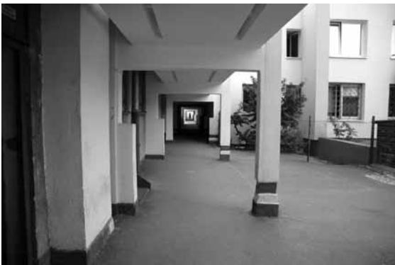
Galerie wzdłuż budynku – przestrzeń publiczno-społeczna zapewniająca komunikację
