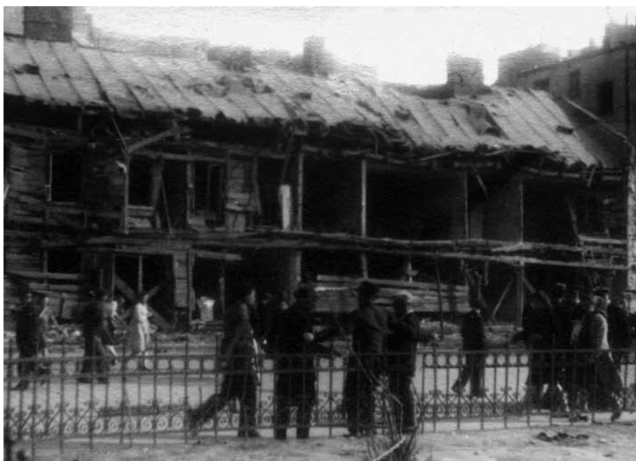
Nalot z 12 na 13 maja 1943 r., uszkodzony budynek, pl. Kazimierza Wielkiego 3. Fot. S. Baranowskiego w depozycie Fundacji „Warszawa1939.pl”
