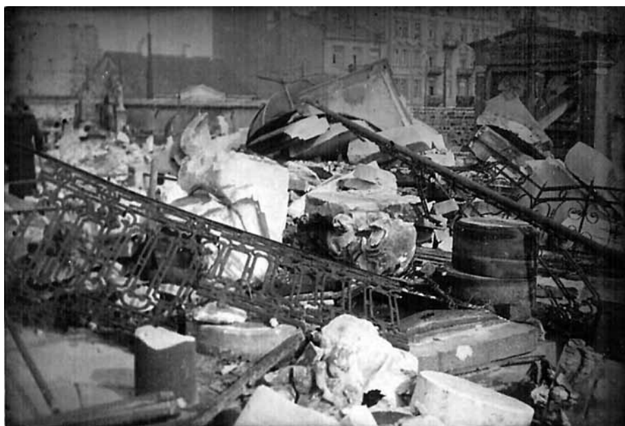
Nalot z 1 na 2 września 1942 r., zniszczone groby na Cmentarzu Powązkowskim. Fot. z archiwum Fundacji „Warszawa 1939.pl”
