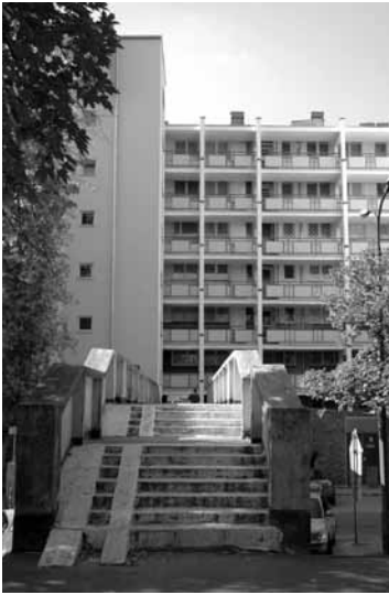
Kładka oddzielająca ruch pieszy od kołowego na terenie osiedla Przyczółek Grochowski
